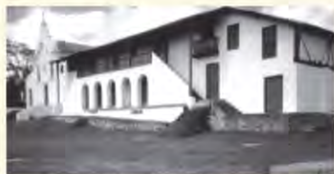
RD11. Mata Norte Vicência Casa-Grande e Capela do Engenho Poço Comprido e seus pertences
